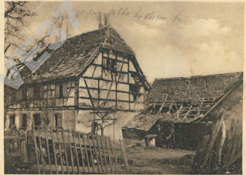
Zerstörtes Gehöft in Schweighausen.
